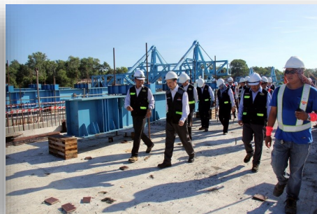
1 Disember 2015 — Menteri Pembangunan mendengar penerangan daripada pegawai di Jabatan Jalan Raya, Jabatan Kerja Raya mengenai projek pembinaan flyover di Meragang.
