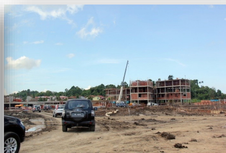
1 Disember 2015 — Menteri Pembangunan melawat ke tapak projek H40 Lambak Kanan yang dibina dibawah Jabatan Kemajuan Perumahan.
